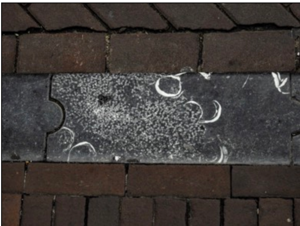
Hoek Leidsegracht / Prinsengracht (brug)
