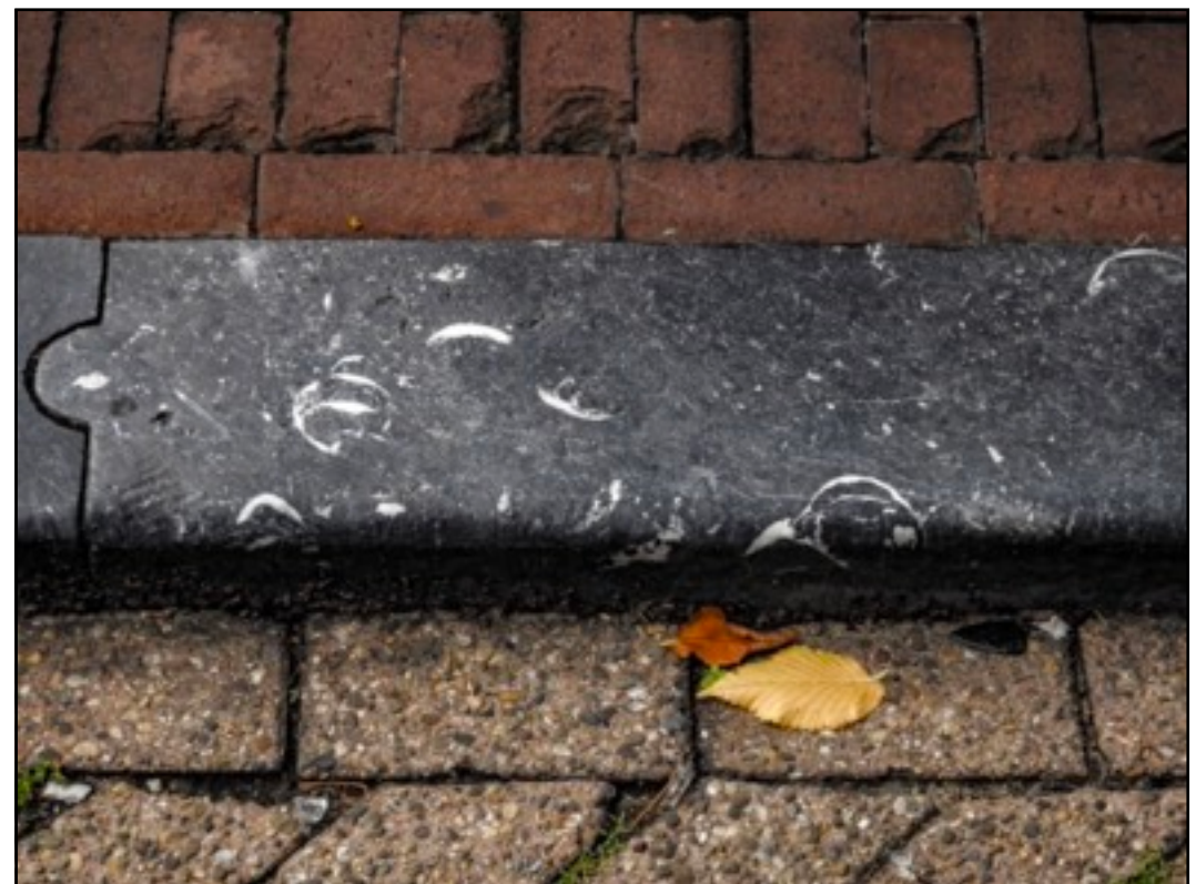
Hoek Leidsegracht / Prinsengracht (brug)
